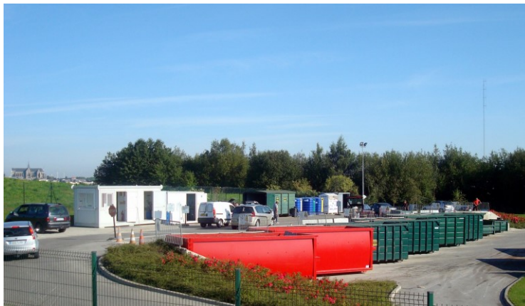
Déchèterie Sud de Gauchy
