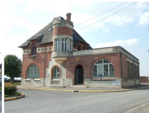
Bureau de poste de Jussy
