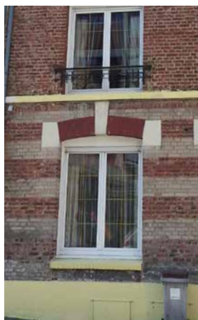
Les fenêtres à petits carreaux sont typiques sur XVIII e siècle. Les petits-bois dorés qui sont actuellement à la mode n'ont pas lieu d'être sur le bâti ancien.
