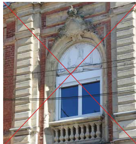
Exemple de transformation très préjudiciable pour le bâti : à gauche la fenêtre originelle en bois moulurée et sculptée et à droite la même fenêtre transformée sans soin avec la création d'un volet roulant.
