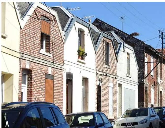
L'alternance façades en brique et façades enduites sur un rythme de façades identiques crée une animation dans la rue
