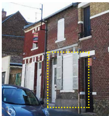
Volets métalliques traditionnels repliés en tableau
