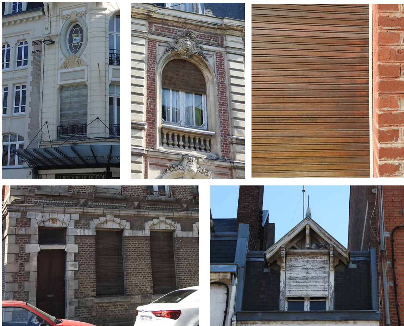
Exemples de volets roulants en bois sur du bâti ancien. Les coffrets roulants sont intégrés à l'intérieur du bâtiment.
