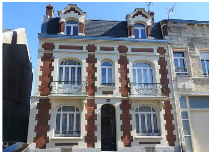
Exemple de rénovation soignée. Les profilés sont plus larges que les anciens mais les dessins et les linteaux cintrés ont été respectés.
