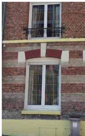
Les fenêtres à petits carreaux sont typiques sur XVIII e siècle. Les petits-bois dorés qui sont actuellement à la mode n'ont pas lieu d'être sur le bâti ancien.
