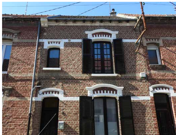
Malgré un souci de valoriser la façade qui est traitée avec soin, les deux fenêtres du RdC et de l'étage sont de typologies différentes. Elles étaient probablement à l'origine toutes les deux à grands carreaux.
