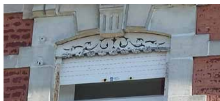
Exemple de lambrequin ouvragé en bois sur baie cintrée
