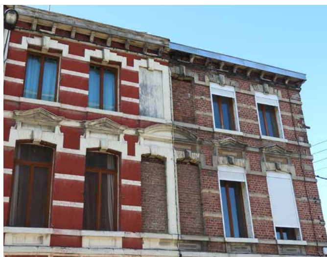
Deux façades identiques peinte ou en brique naturelle
