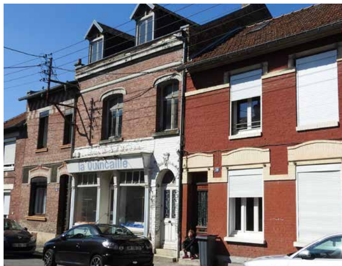
Façades en briques naturelles et peintes
