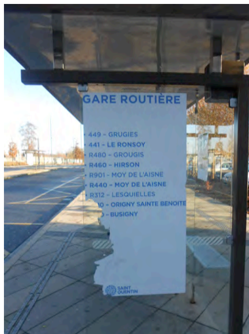
Dégradation sur certains arrêts (ITEM)
