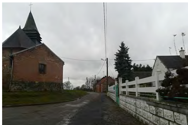
Trottoirs non aménagés à Sommette –Eaucourt (ITEM)
