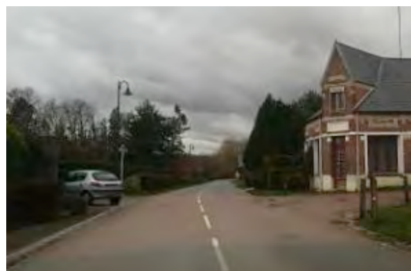
Revêtement coloré aux croisements – Happencourt (ITEM)
