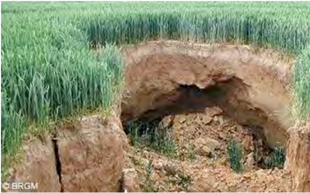
Effondrement de cavité (BRGM)
