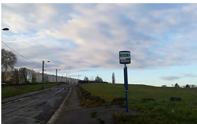
Arrêt « Noirmont » non conforme (ITEM)
