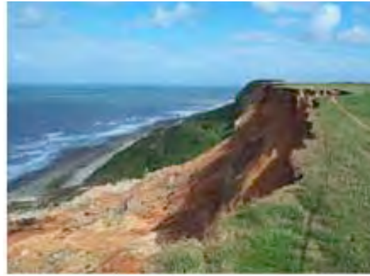
Glissement de terrain (Géorisques)
