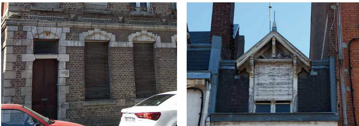
Exemples de volets roulants en bois sur du bâti ancien. Les coffrets roulants sont intégrés à l'intérieur du bâtiment.
