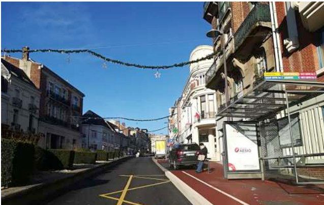
Arrêt « Isle » répondant aux normes d'accessibilité (ITEM)
