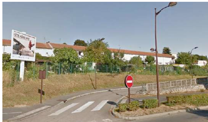
Intersection peu sécurisée rue Emile et Raymond Pierret (ITEM)
