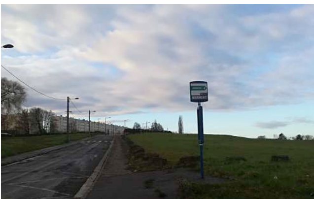
Arrêt « Noirmont » non conforme (ITEM)
