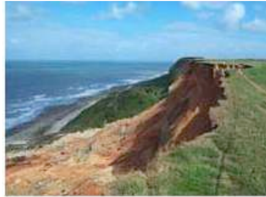
Glissement de terrain (Géorisques)
