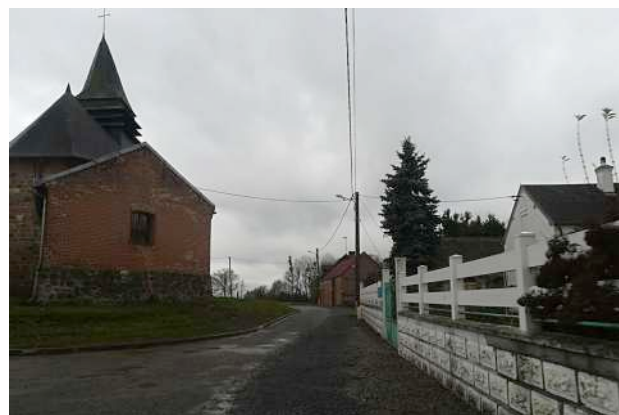
Trottoirs non aménagés à Sommette –Eaucourt (ITEM)
