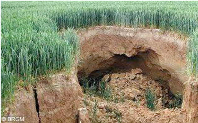
Effondrement de cavité (BRGM)
