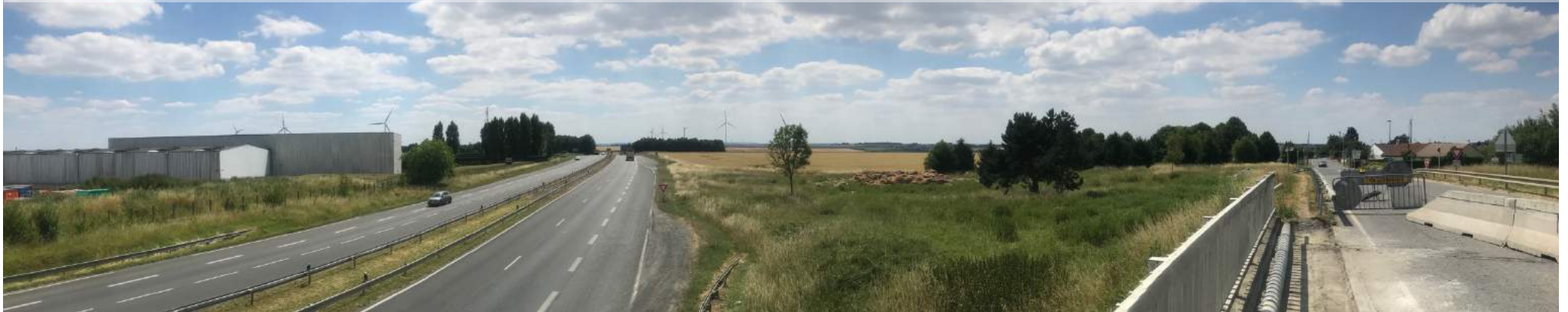
Vue sur le secteur de projet depuis le pont de la D1
