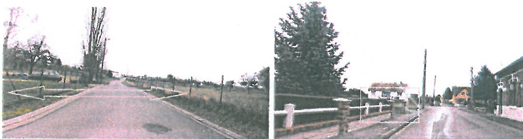
En face du collège rue de la Fere
