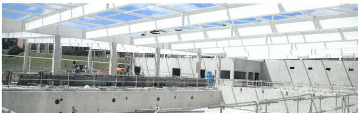
Extension et rénovation de la piscine Jean Bouin à Saint-Quentin
