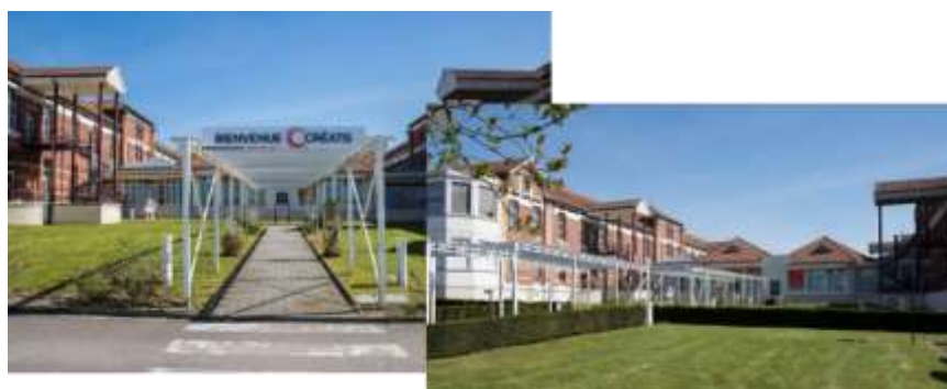
Espace Créatis à Saint-Quentin
