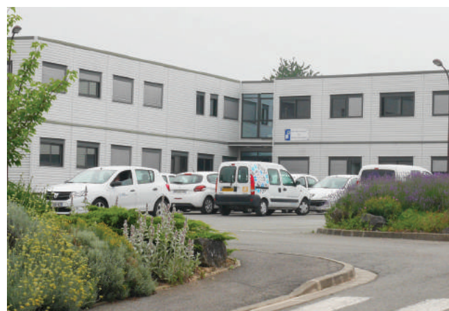
Centre Technique d'Agglomération (CTA)
