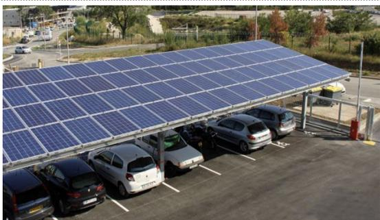
Exemples d'implantation de panneaux solaires sur les toitures d'ombrières
