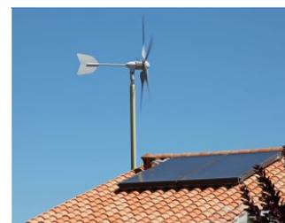
Exemple d'éolienne horizontale sur toiture
