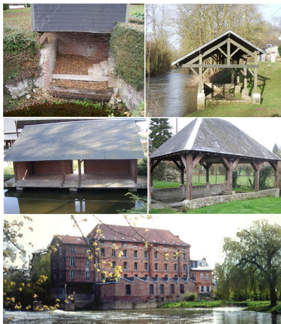
Lavoir fontaine de la Vierge à Sissy, lavoirs de Caulaincourt, Ollezy et Brissy-Hamegicourt, moulin de Lucy à Ribemont.
