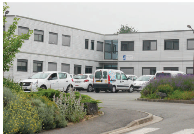
Centre Technique d'Agglomération (CTA)
