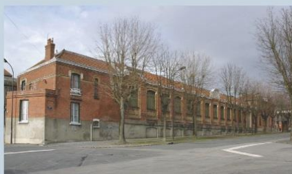
Ancien logement de contremaître et façade des ateliers
